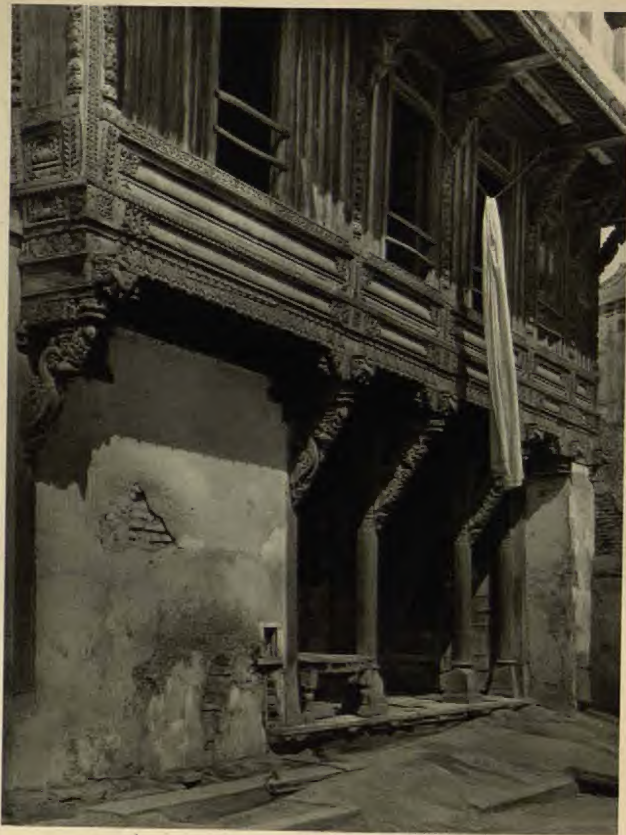
Ahmedabad. Haus mit Holzschnitzerei Ahmedabad. Maison avec sculptures sur bois
